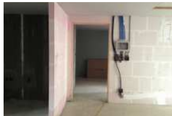
아파트 내 경량벽체를 설치한 모습
